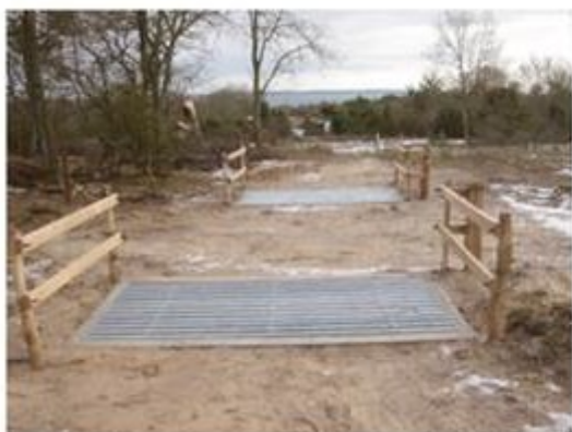
Færist med paddesikring. Eksempel på færist med paddesikring, hvor padderne har mulighed for at kravle ud gennem røret vist på billedet til højre.
