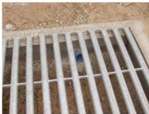
Færist med paddesikring. Eksempel på færist med paddesikring, hvor padderne har mulighed for at kravle ud gennem røret vist på billedet til højre.
